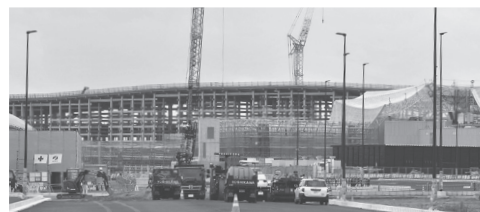
建設中の万博会場
