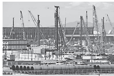
万博・大屋根リング（中央奥）の北側で進むカジノリゾート建設＝7月下旬、大阪市此花区夢洲
